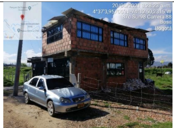
Fotografía 8. Presencia de RCD en el PEDHLS, resultado de construcciones dentro del sector - área legal
