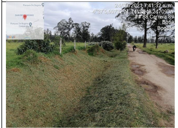
Se evidenció corte de pasto kikuyo en el canal perimetral del sector 1 PEDHLS.
