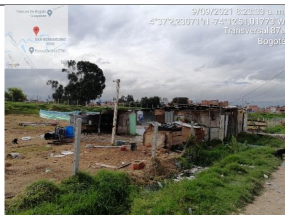
Fotografía 4. Asentamiento no legalizado en madera en el sector conocido como biofiltro del PEDHLS – estructura 3
