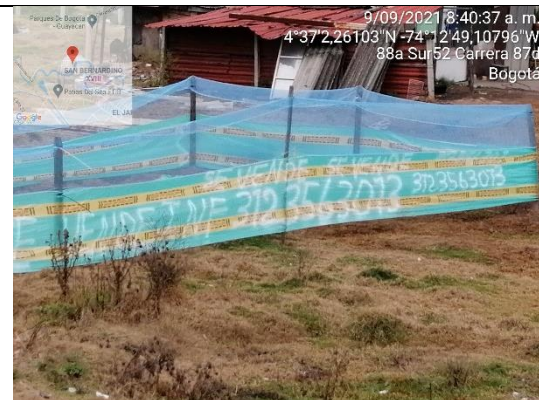
Fotografía 59. Verificación de tensionantes (instalación de polisombra por presunto invasor para presunta construcción y presunto ofrecimiento de predios)
