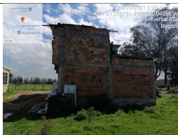
Fotografía 2. Asentamiento no legalizado consolidado en el sector conocido como biofiltro del PEDHLS – estructura 1 (lateral)
