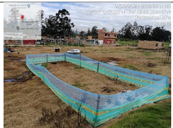
Fotografía 24. Se evidencia instalación de polisombras para presuntas construcciones
