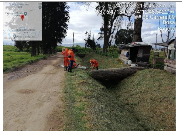
Se evidenció corte de pasto kikuyo en el canal perimetral del sector 1 PEDHLS.
