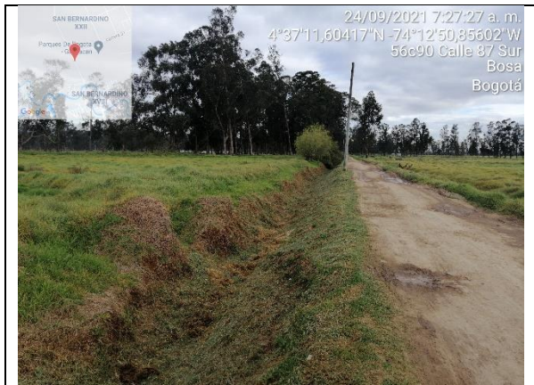
Se evidenció corte de pasto kikuyo en el canal perimetral del sector 1 PEDHLS.
