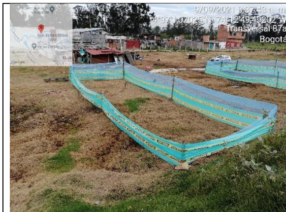
Fotografía 23. Se evidencia instalación de polisombras para presuntas construcciones
