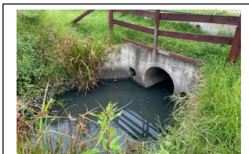
Fotografía 2 Colector de aguas, sector II perteneciente del barrio Rincón santo
