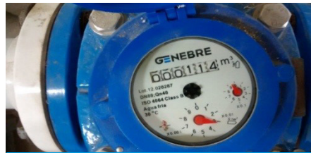
Medidor que permite registrar la cantidad de agua en metros cúbicos (m 3 ).
