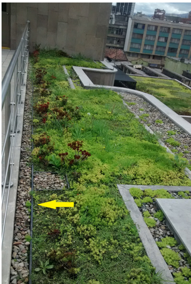
Sistema de recolección y filtración por membranas de agua lluvia y riego en techos verdes.
