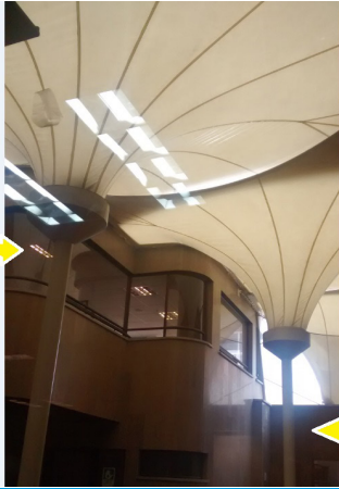
Embudos de recolección de agua lluvia en la zona de cafetería.
